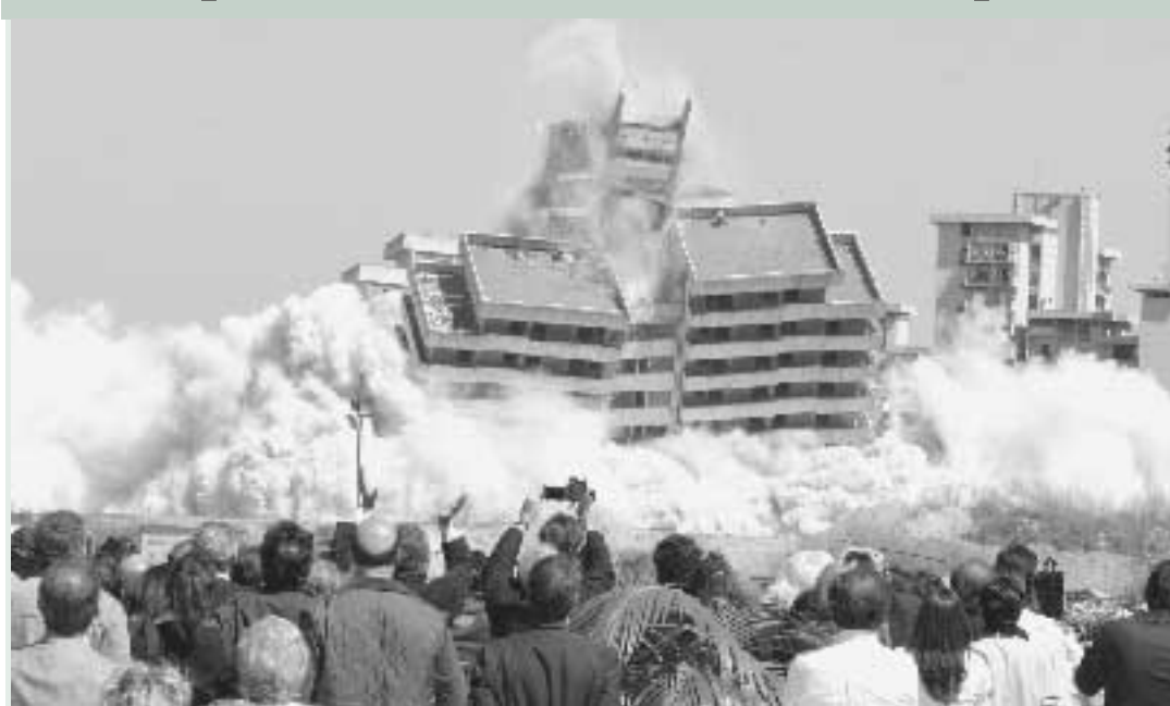
NAPOLI La Vela H del rione Scampia, enorme palazzo diventato uno dei simboli del degrado e del disagio di un intero quartiere, è stata abbattuta oggi a Napoli alla
