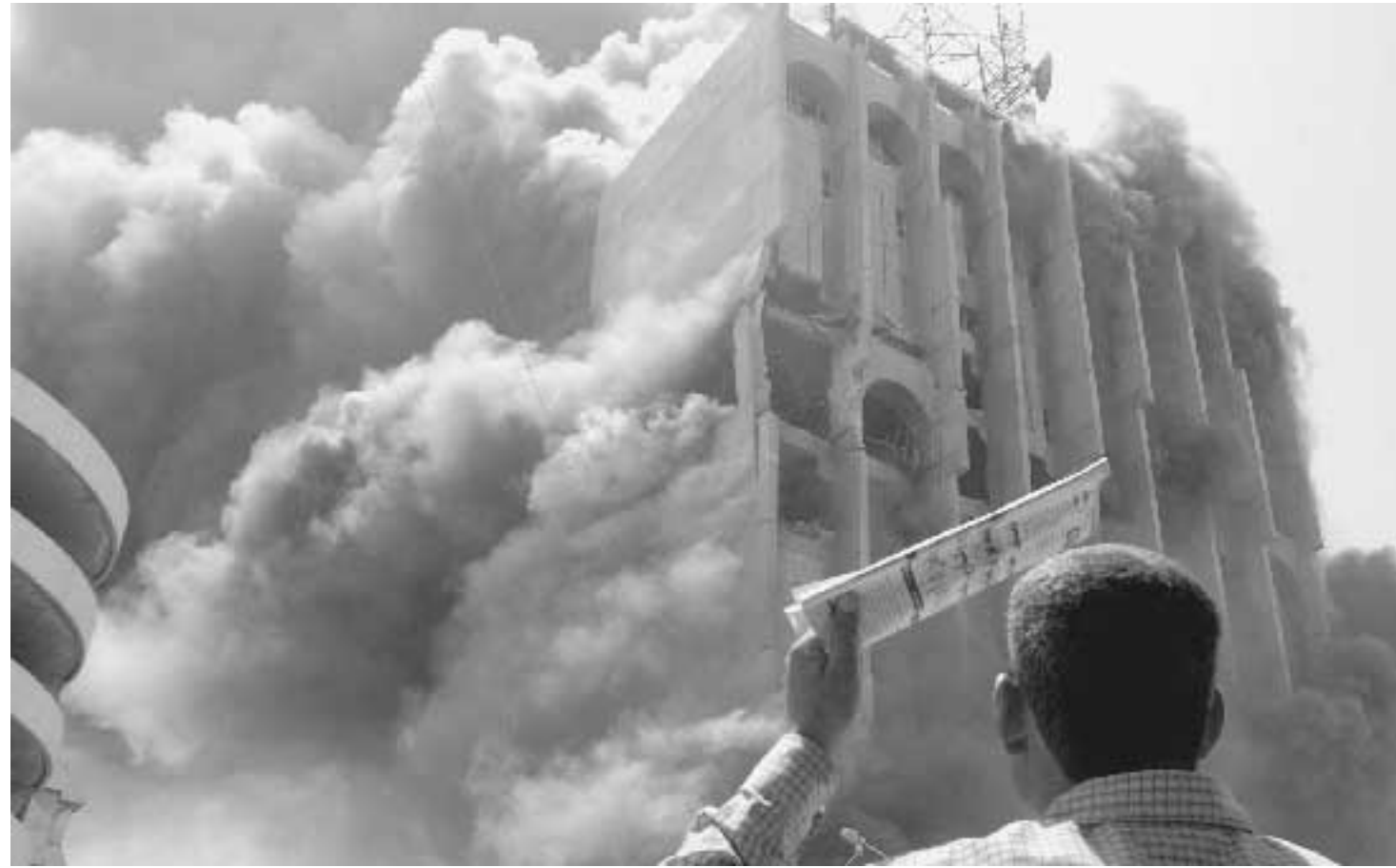
L'incendio che ha avvolto ieri il palazzo delle telecomunicazioni al centro di Baghdad
