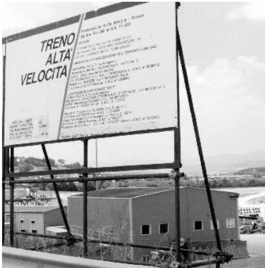
Il cantiere del Mugello per l'alta velocità tra Firenze e Bologna
