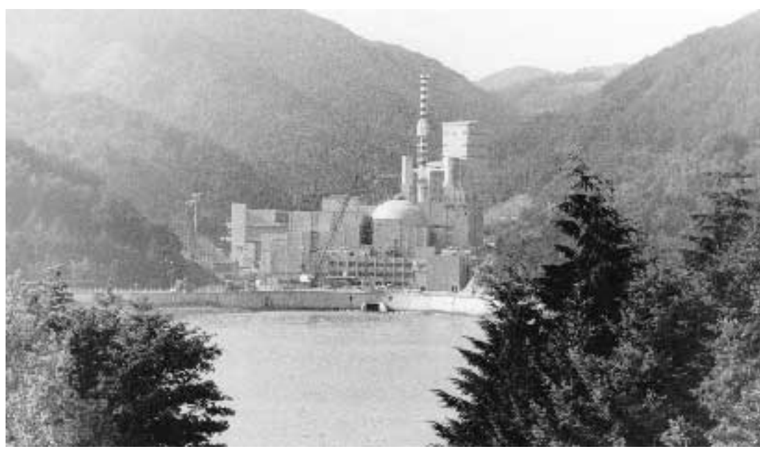
Una centrale idroelettrica
