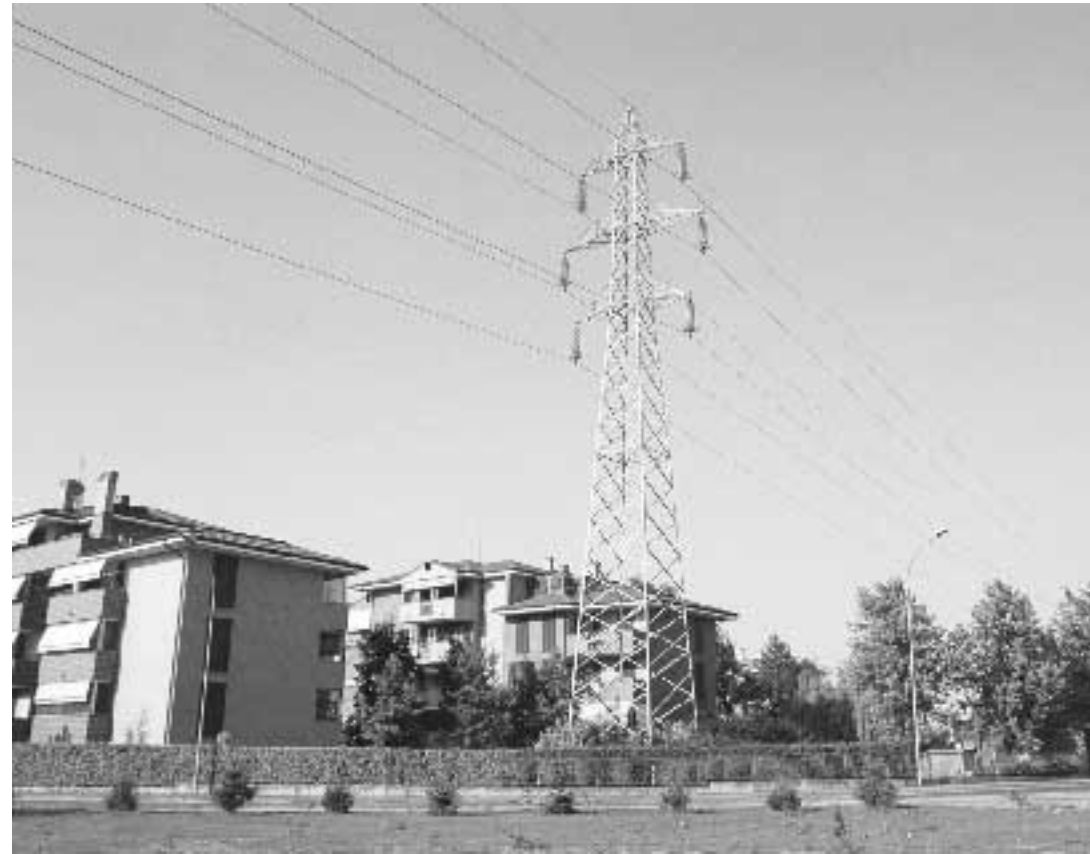
Un traliccio dell'alta tensione all'interno di un condominio
