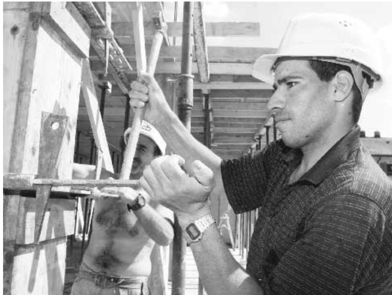
Un operaio immigrato al lavoro in un cantiere
