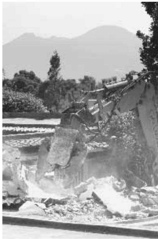
Abbattimento della Villa Gaiola a Posillipo C.Fusco/Ansa
