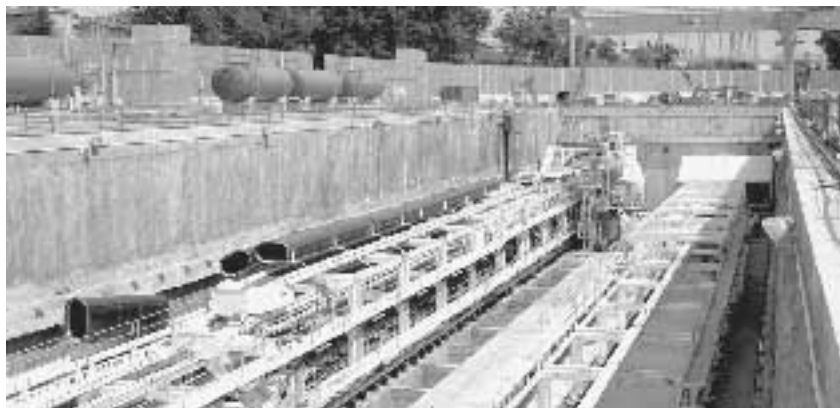
Un cantiere dell'alta velocità ferroviaria
