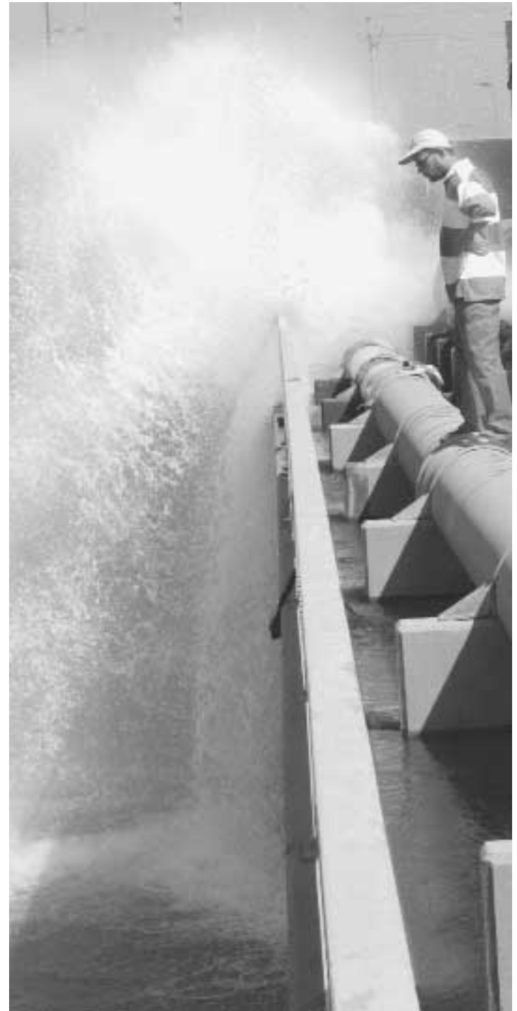
La falla sulla condotta dell'acquedotto, in alto gente fugge davanti al carcere
