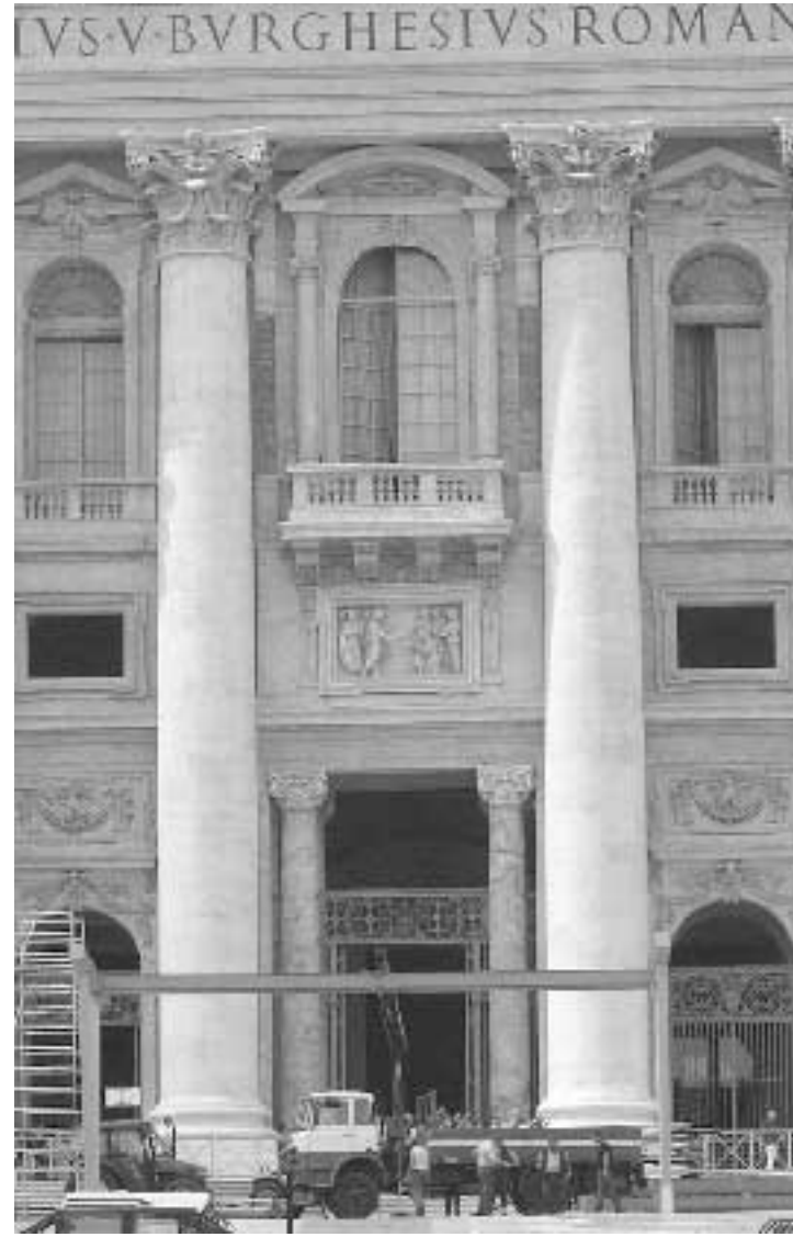
Il luogo dove è caduto un operaio che stava lavorando in piazza San Pietro
