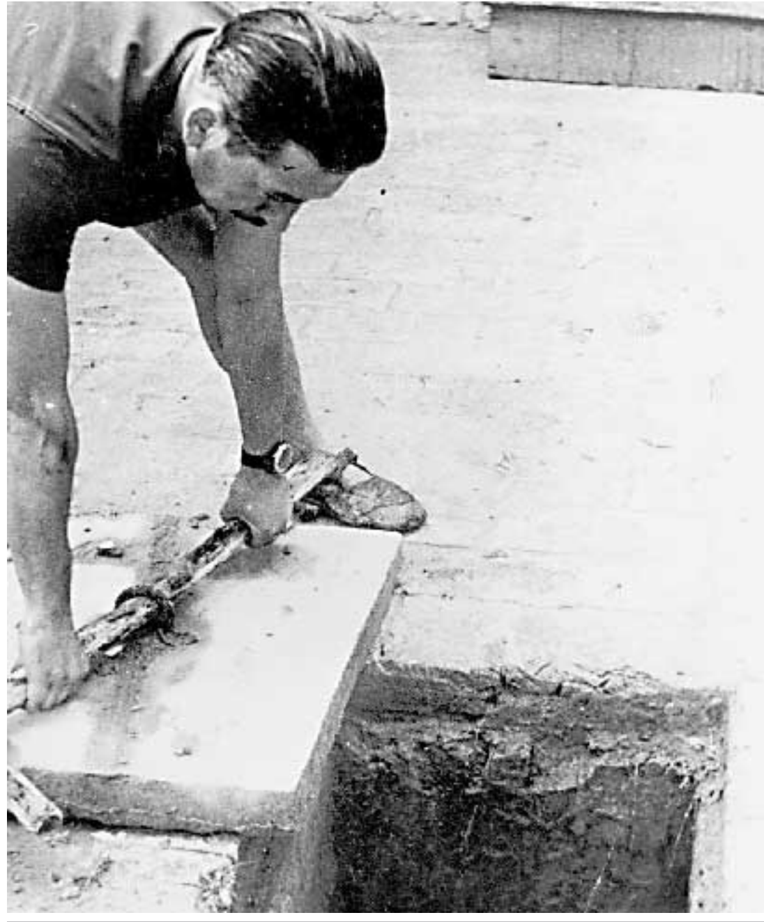
Un pozzo usato per occultare le vittime della strage di Marzabotto
