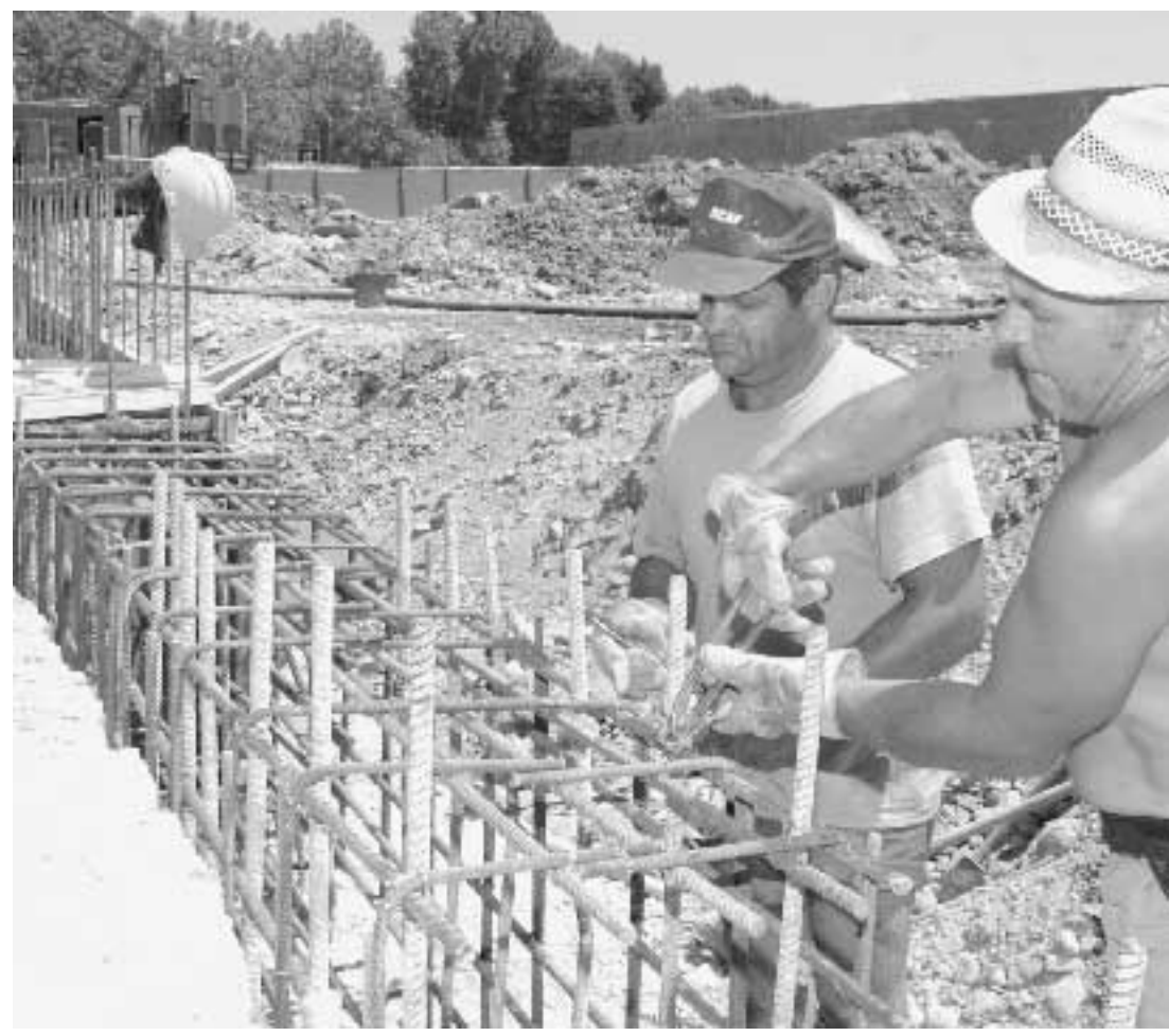
Operai al lavoro in un cantiere edile
