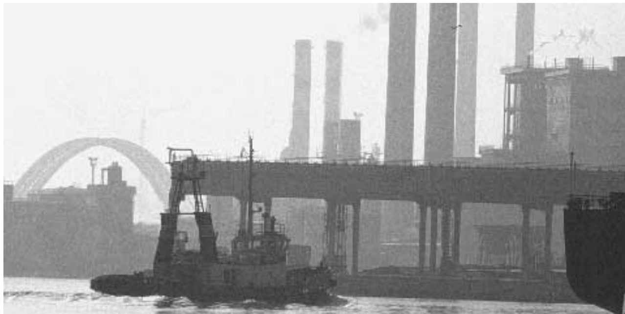
L'area industriale di Porto Marghera
