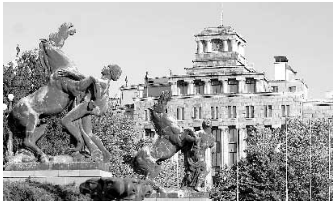
La sede della società di telecomunicazioni Telekom Serbia a Belgrado
