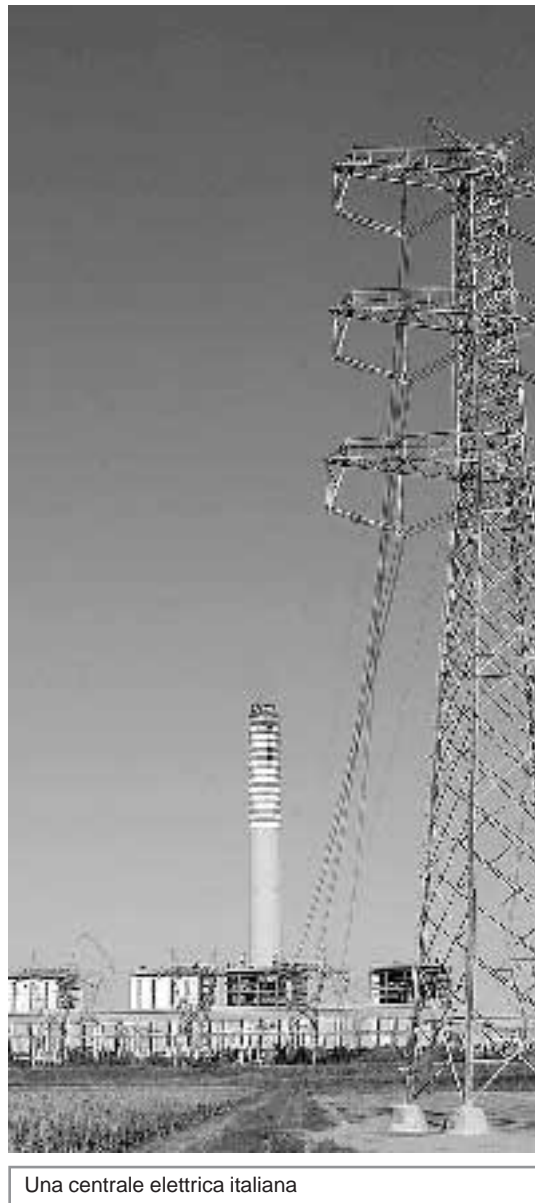
Una centrale elettrica italiana
