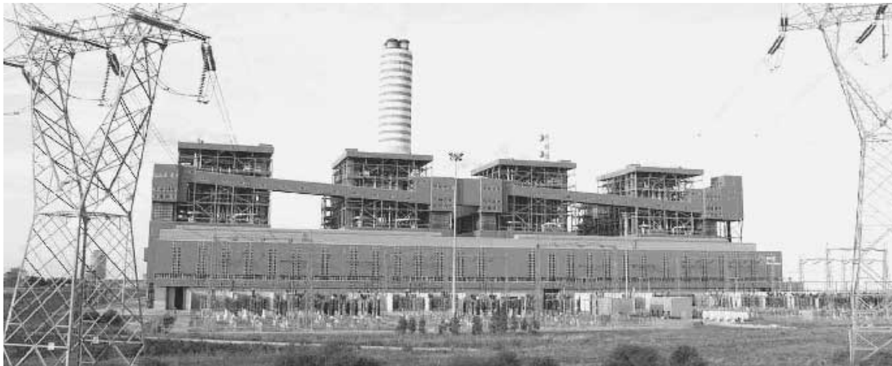
La centrale idroelettrica di Brindisi
