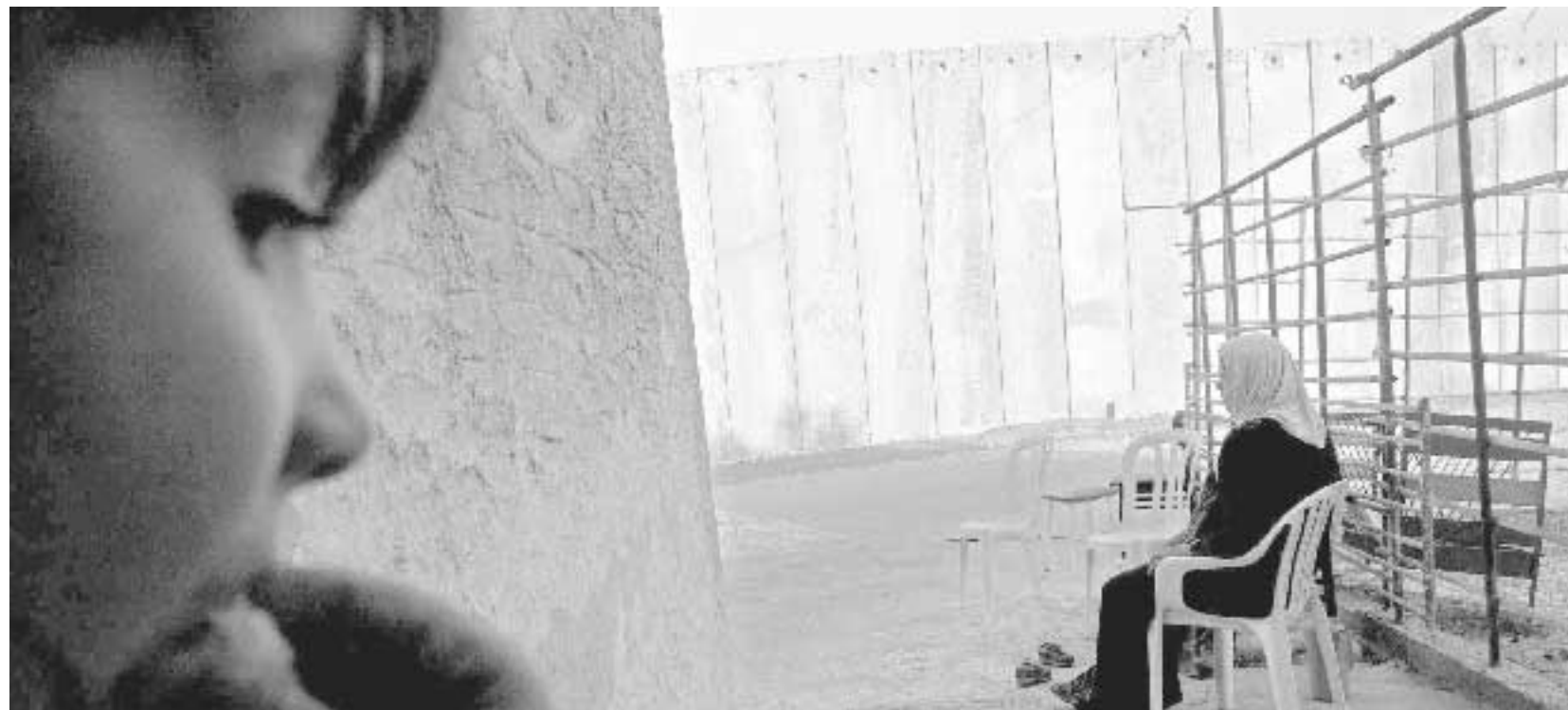
La costruzione del muro nel villaggio di Masha a pochi metri da una abitazione palestinese
