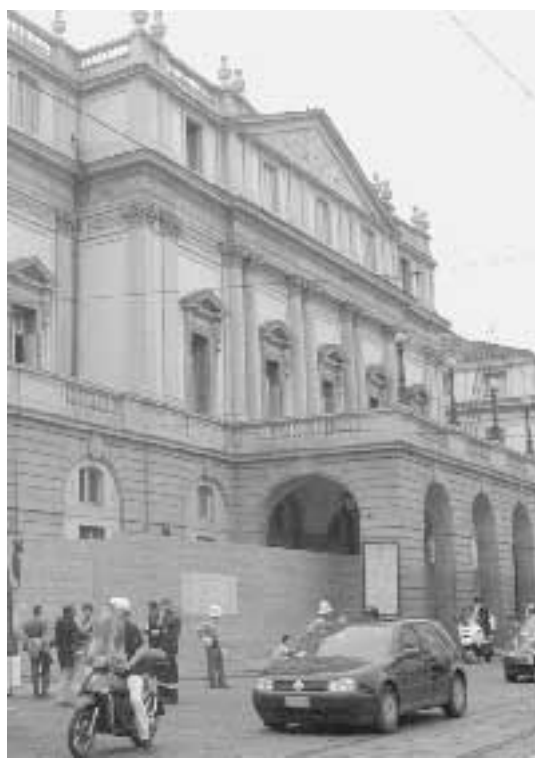
I lavori di ristrutturazione della Scala affidati al Ccc
