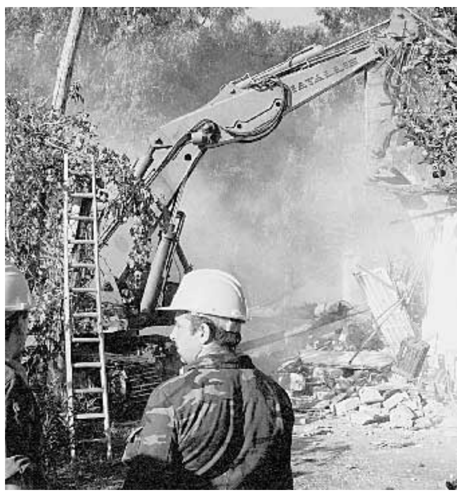
Demolizioni di fabbricati abusivi nel Comune di Eboli
