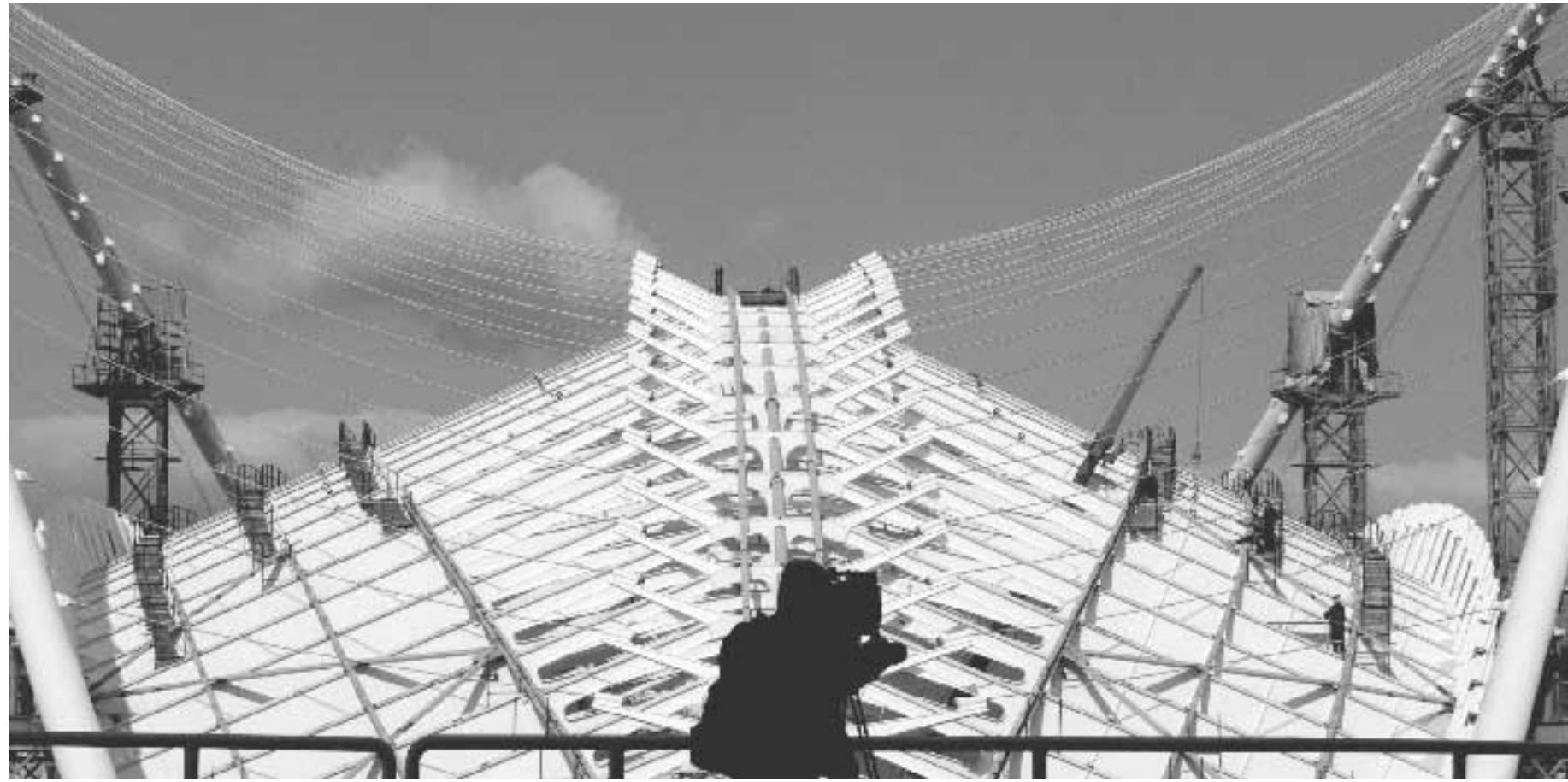
Una veduta del tetto in costruzione sul velodromo di Atene per le Olimpiadi del prossimo agosto
