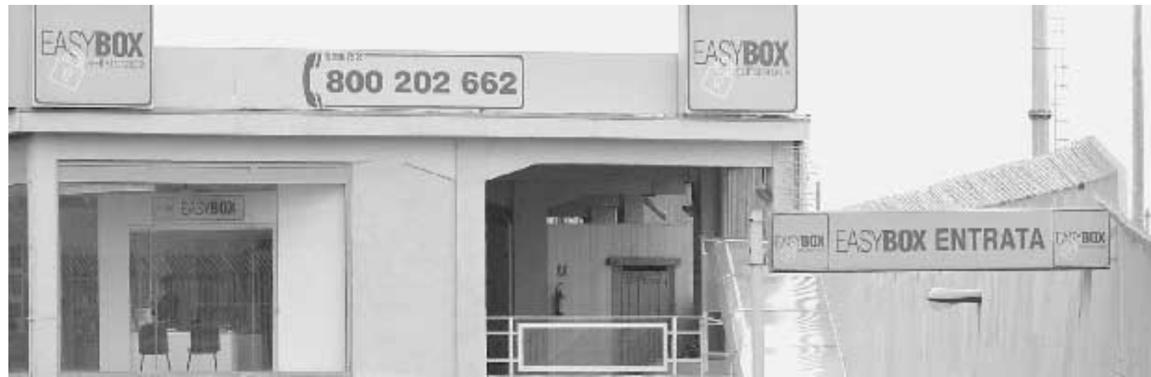
Il deposito Easy Box, vicino al Verano, a Roma, le cui telecamere hanno ripreso la stessa donna che ha firmato il contratto di affitto del covo di via Montecuccoli Di Meo/Ansa
