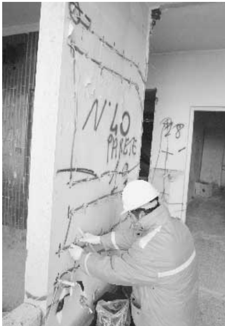
Si preparano le cariche esplosive alle torri di via Artom
