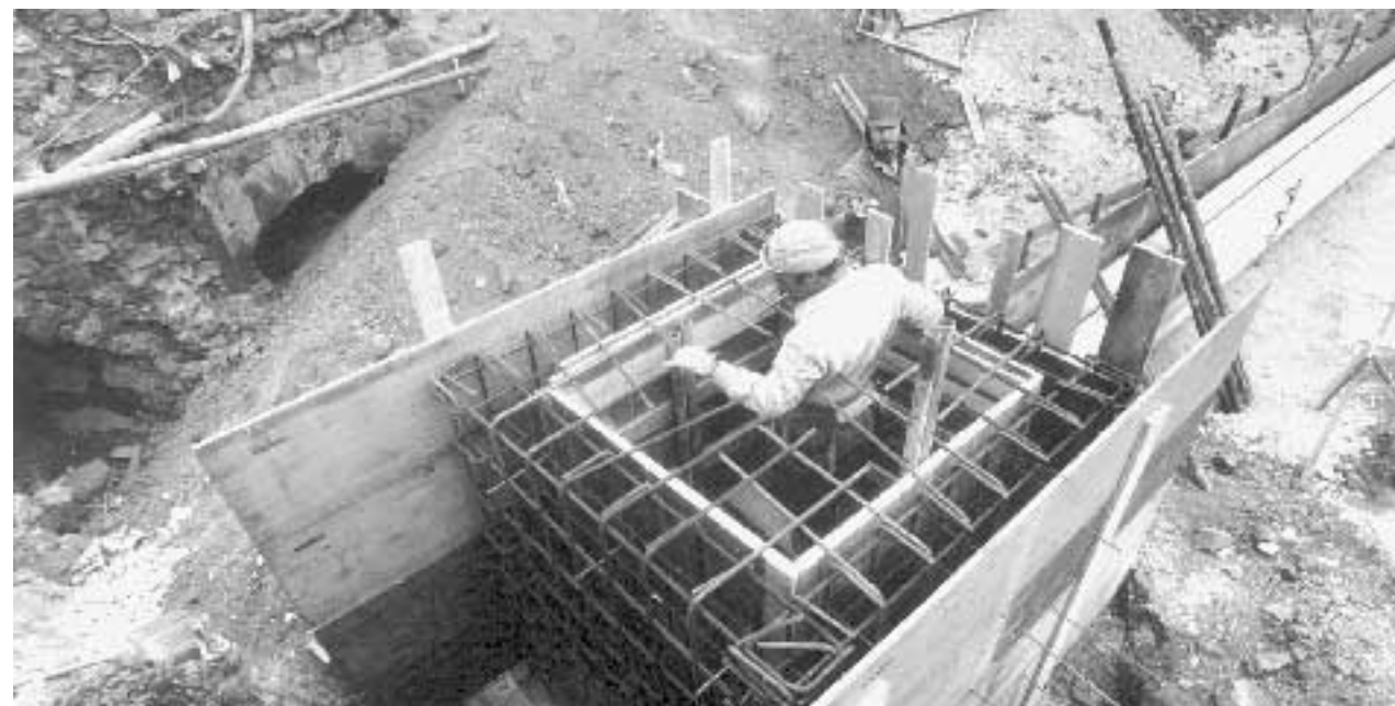
Un operaio al lavoro in un cantiere edile Foto di Antonio Tataro
