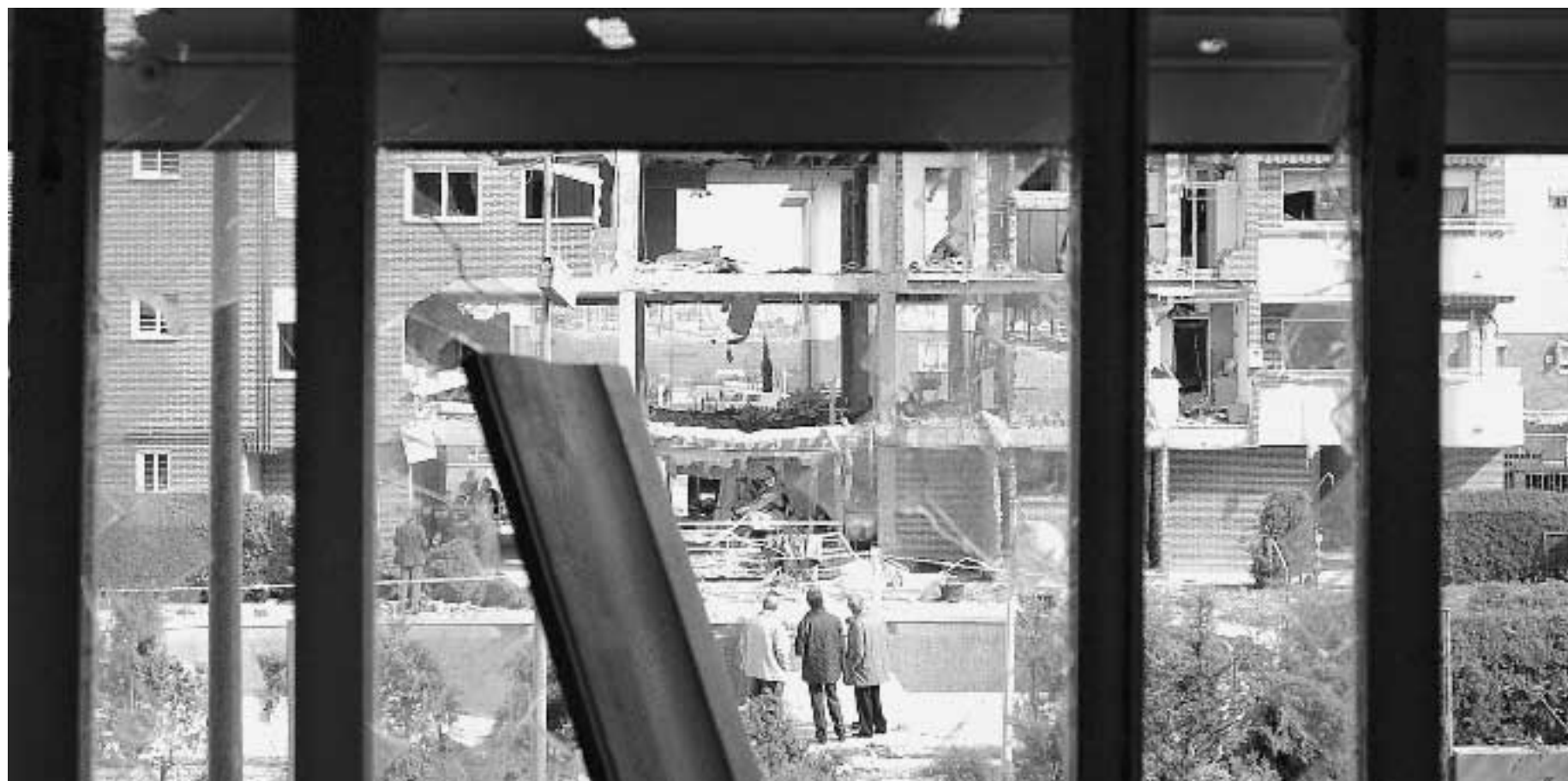
La palazzina distrutta dall'esplosione di sabato a Madrid
