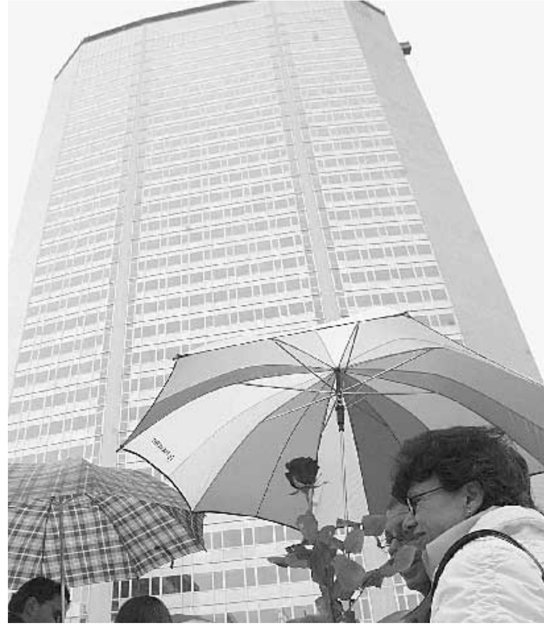
La cerimonia dell'inaugurazione del Pirellone dopo la ristrutturazione
