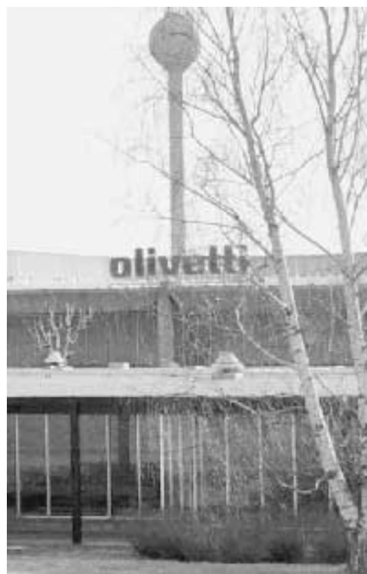
Lo stabilimento ex Olivetti di Scarmagno, vicino Ivrea
