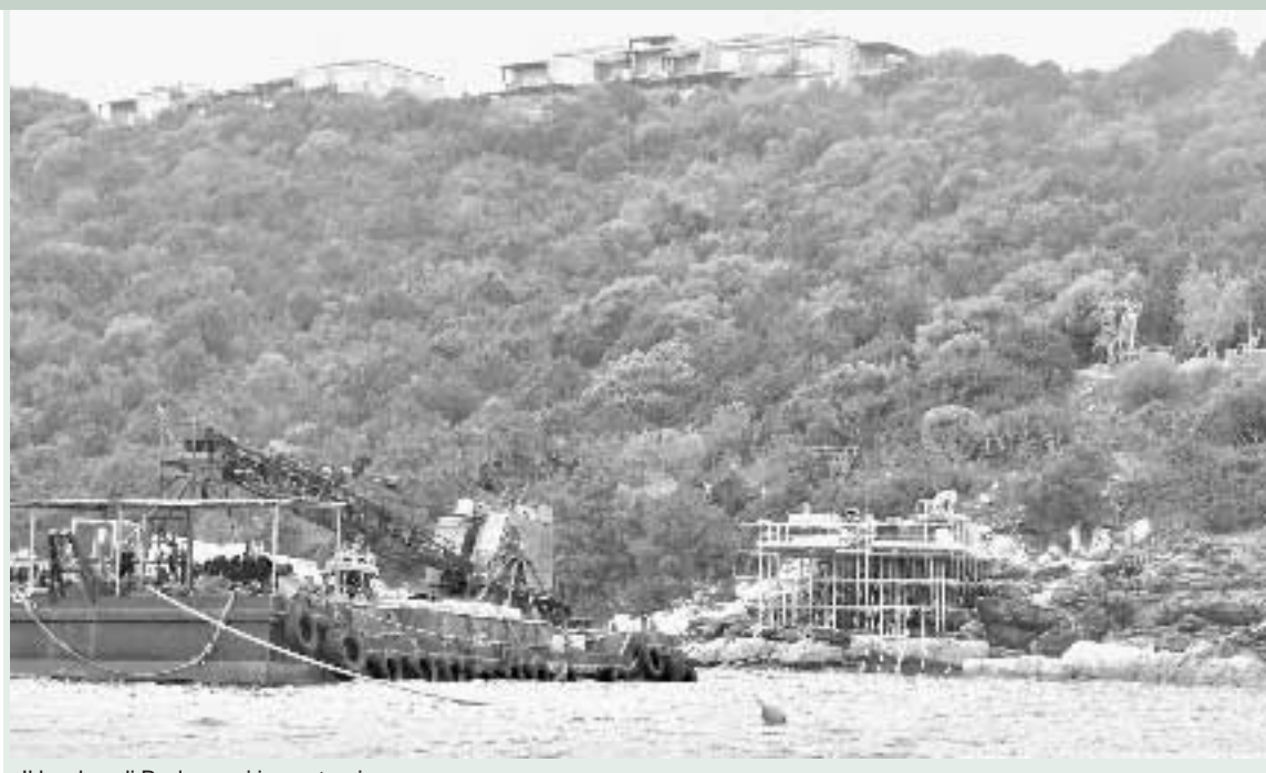
Il bunker di Berlusconi in costruzione. Per gentile concessione de «La Nuova Sardegna»
