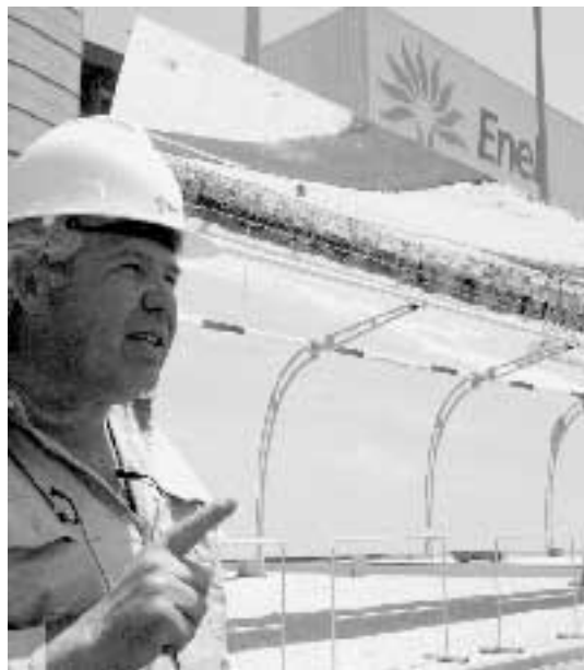
L'impianto solare di Priolo
