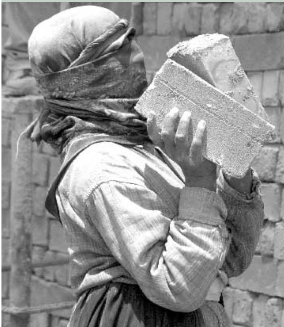
Distruzione e ricostruzione: l'interno di una fabbrica di mattoni fatti a mano a Hillah, in Iraq
