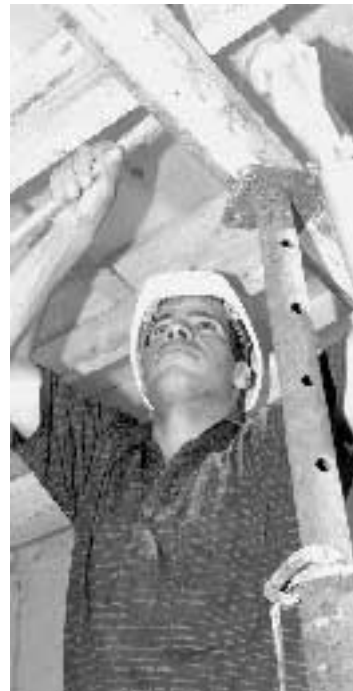
Un operaio immigrato al lavoro in un cantiere Foto di Dal Zennaro/Ansa
