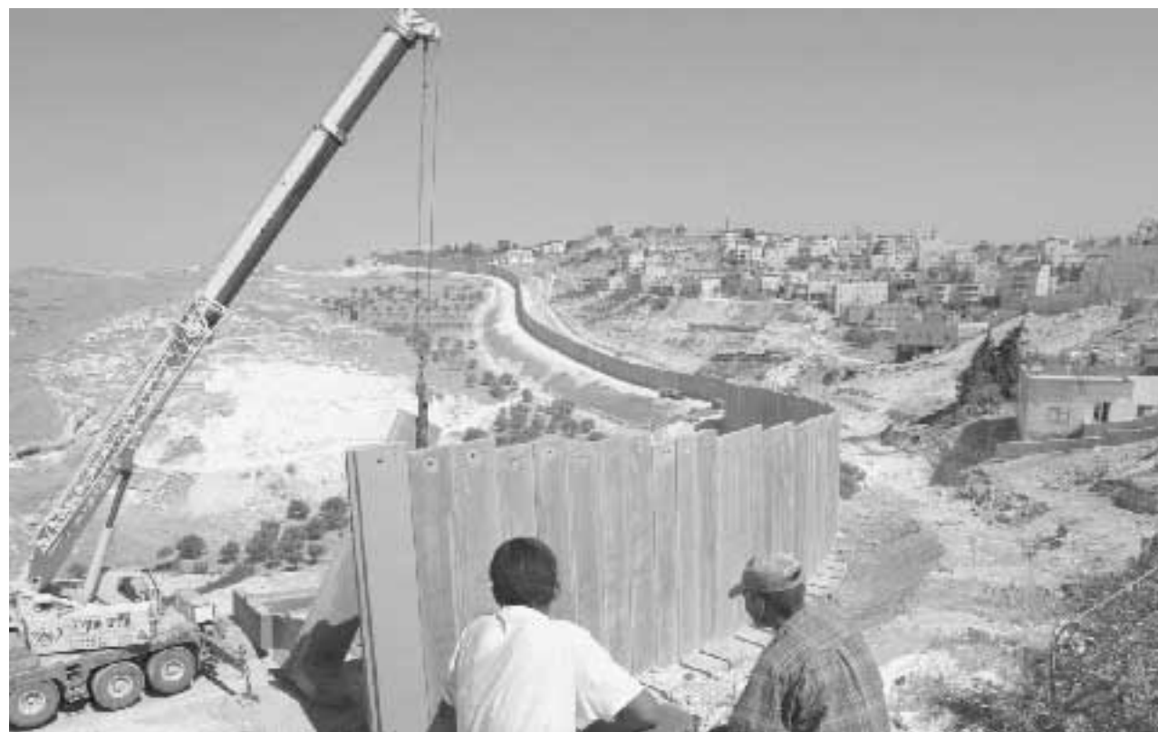
Due palestinesi controllano i lavori della costruzione del muro israeliano
