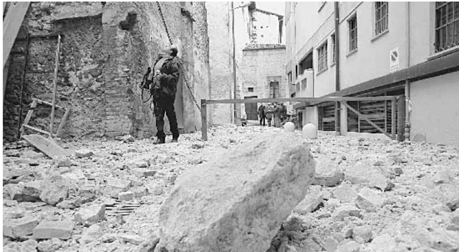
Abitanti di Salò in strada ieri controllano i danni dopo la scossa di terremoto avvenuta intorno alla mezzanotte di mercoledì
