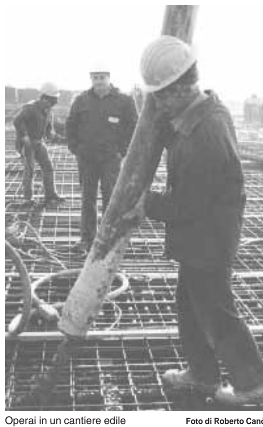
Operai in un cantiere edile
