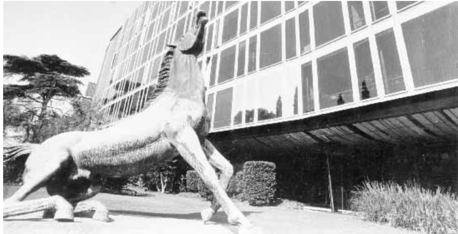
La sede Rai di viale Mazzini
