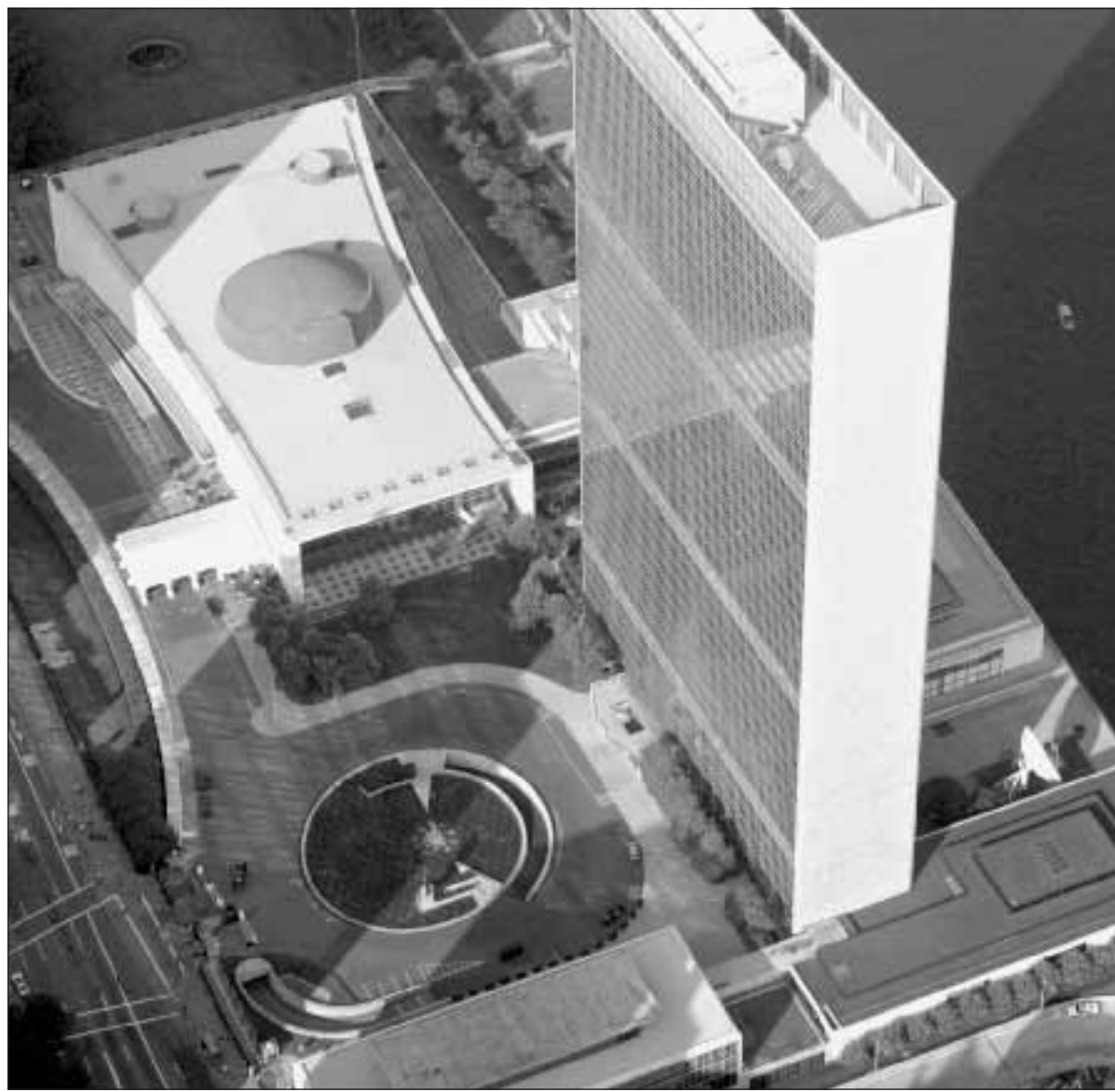
Una vista aerea del Palazzo di vetro sede dell'Onu a New York. Foto di Kathy Willens/Ap
