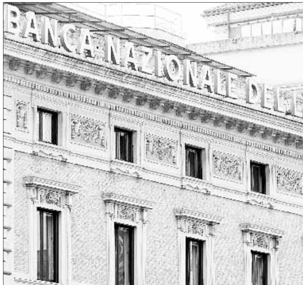
La sede della Banca Nazionale del Lavoro in Via Veneto a Roma. Foto di Maurizio Brambatti/Ansa
