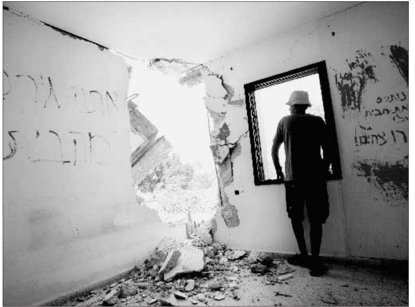
Un colono all'interno della sua abitazione prima che inizi la demolizione. Foto di Nir Elias/Reuters
