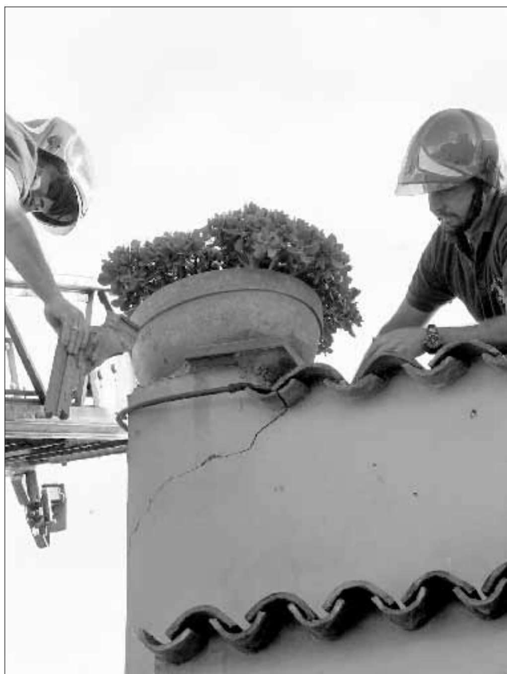
Vigili del fuoco al lavoro a Nettuno dopo la scossa di terremoto Claudio Peri/Ansa
