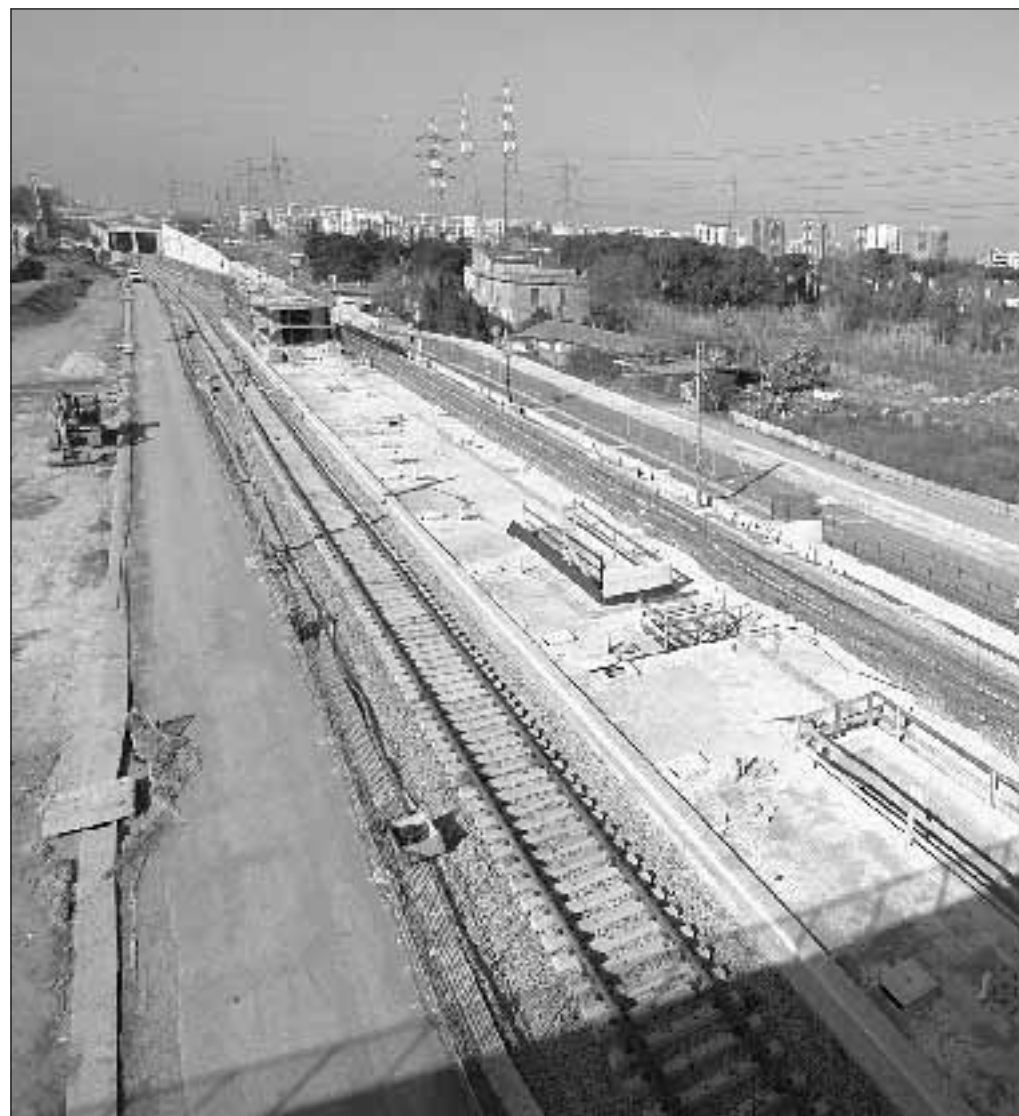
Un tratto del cantiere per la linea ad alta velocità Roma Napoli Foto di Andrea Sabbadini
