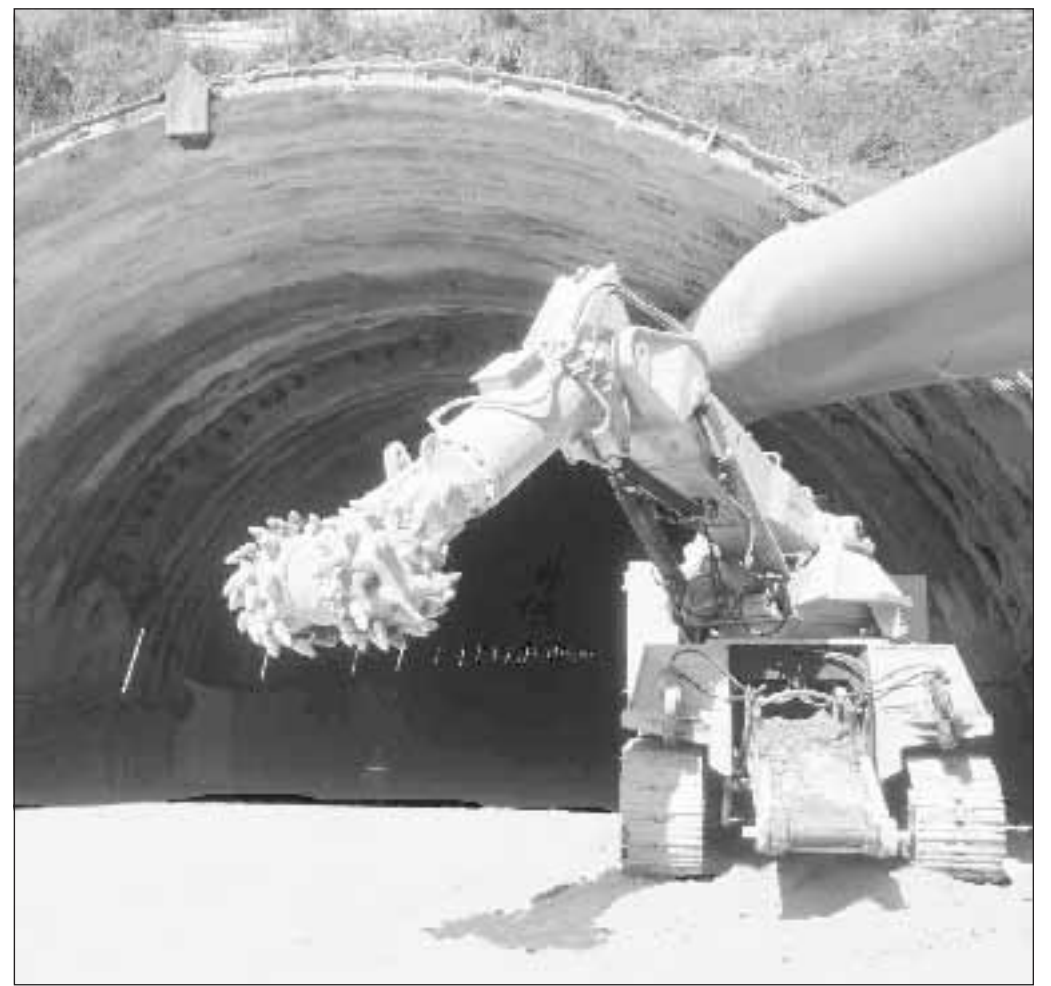
Un cantiere sull'autostrada Salerno-Reggio Calabria
