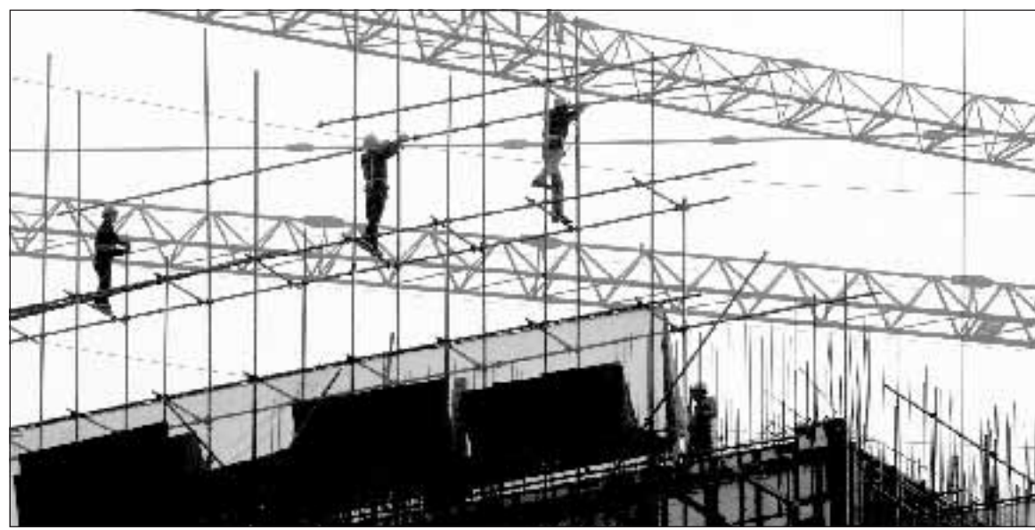
Operai al lavoro in un cantiere edile. Foto Ap
