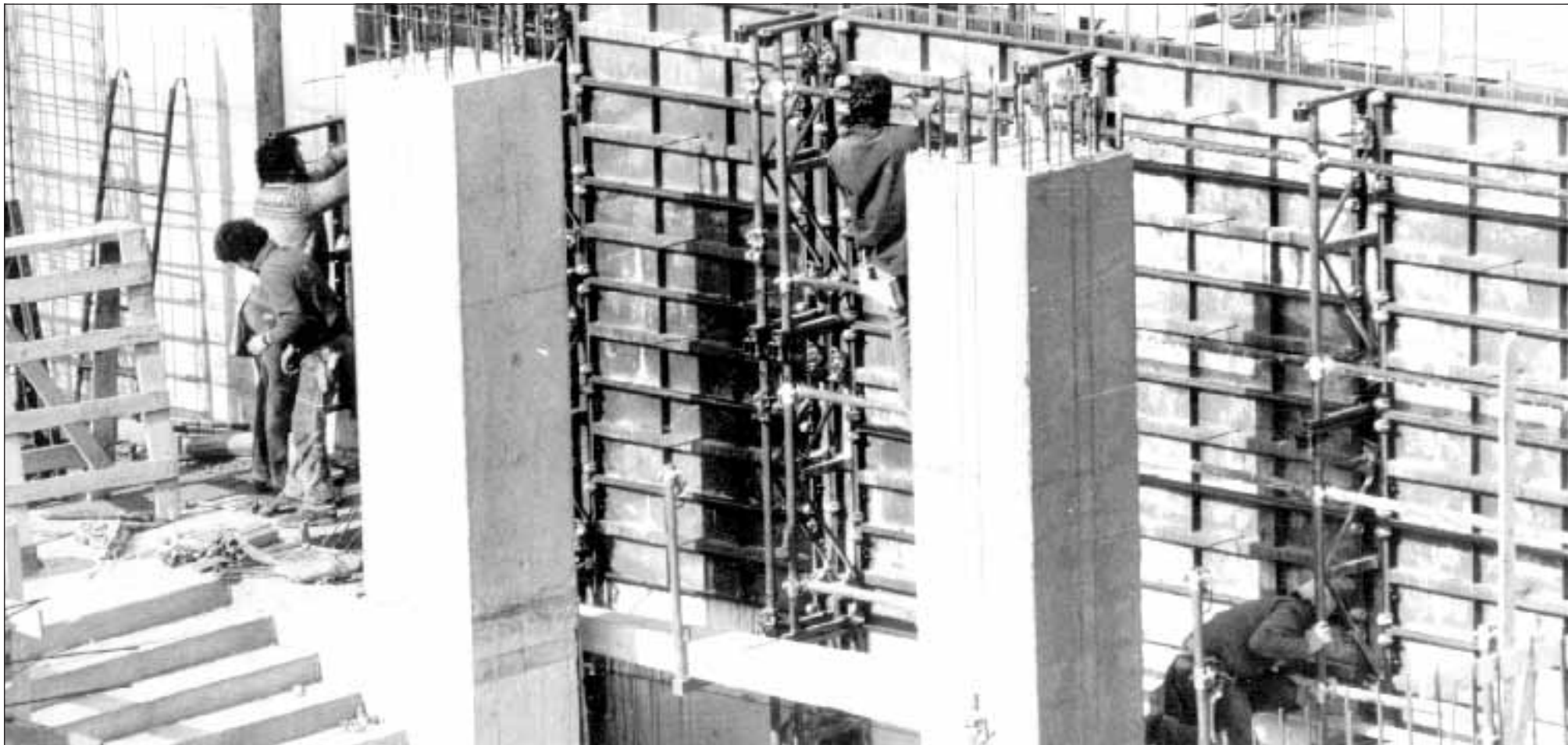
Operai al lavoro in un cantiere edile. Foto Archivio Unita
