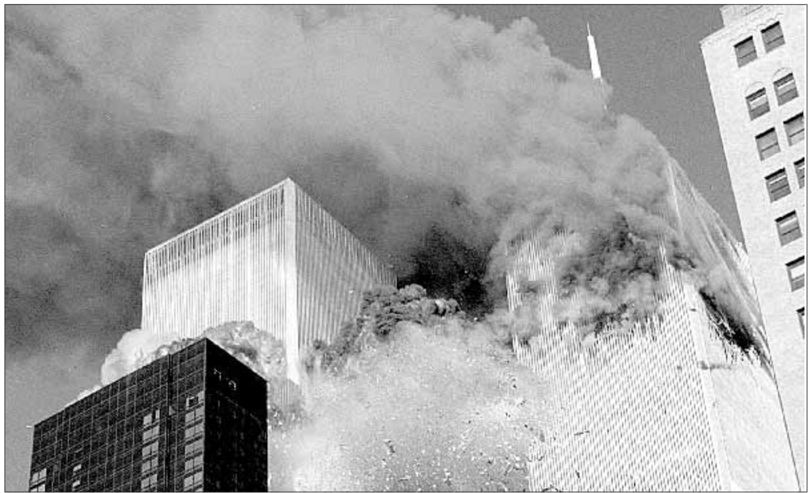
Gli edifici del World Trade Center in fiamme, gli aerei con a bordo i kamikaze hanno appena sventrato le Torri: il cielo è una cappa di polvere
