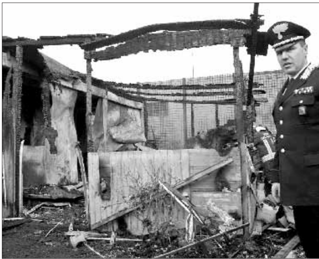
Il container distrutto dalle fiamme nel campo rom. Foto Omniroma
