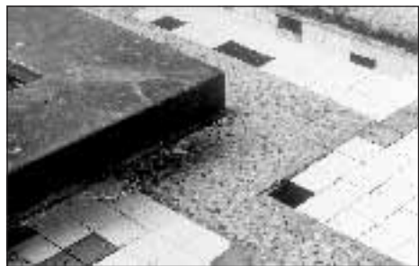
Un particolare del pavimento della Querini Stampalia
