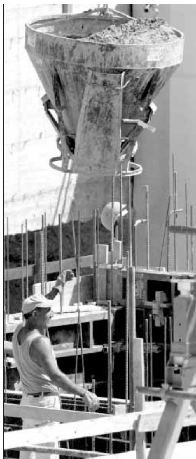
Operai in un cantiere edile Foto di Dario Orlandi
