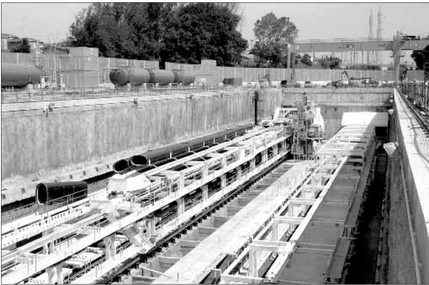
Un cantiere per la realizzazione di un tunnel per la Tav. Foto di Giorgio Benvenuti/Ansa
