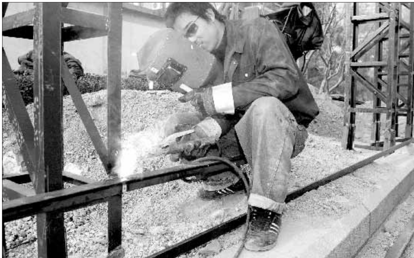
Operai al lavoro
