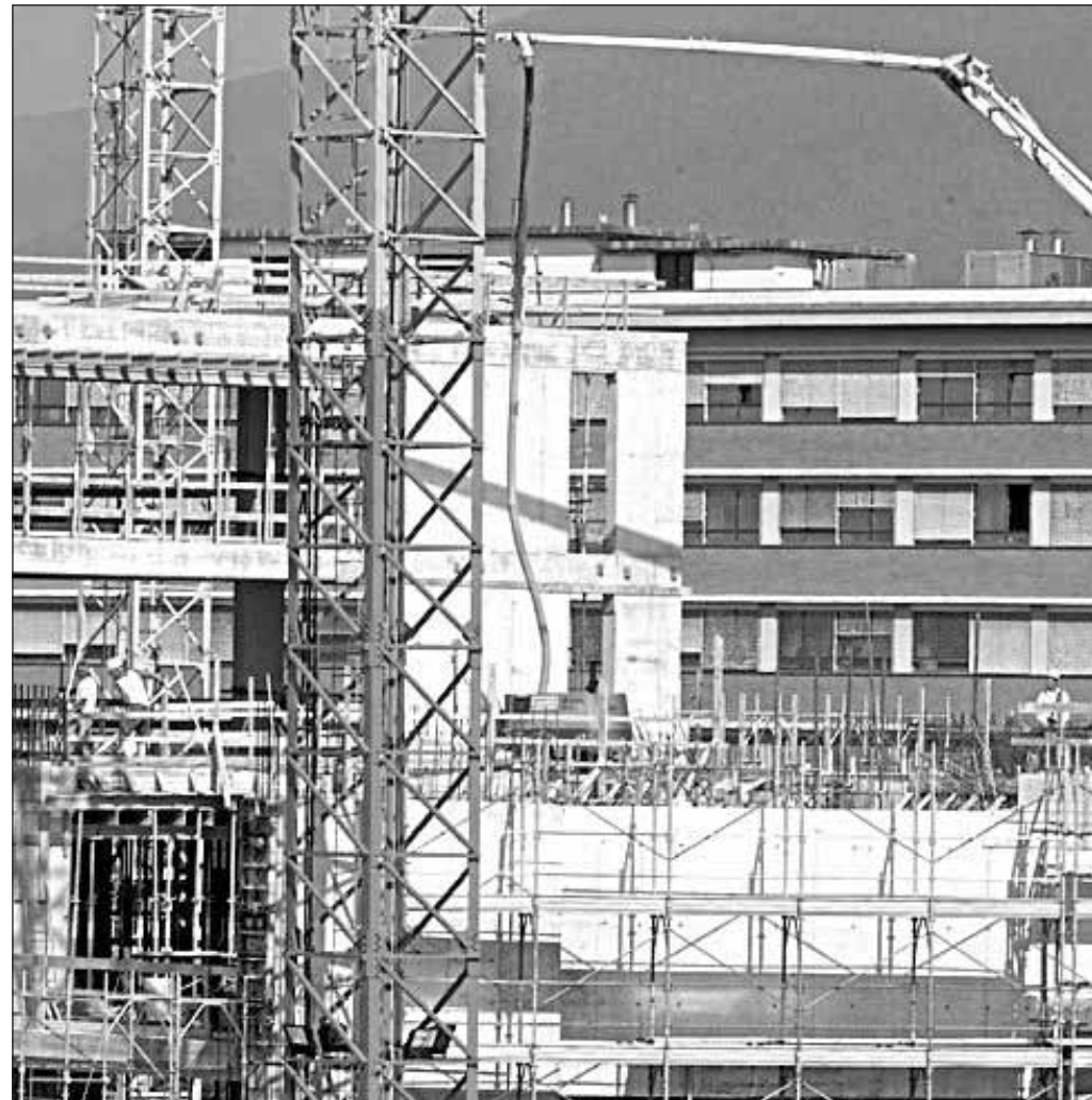
Operai in un cantiere edile Foto di Dario Orlandi
