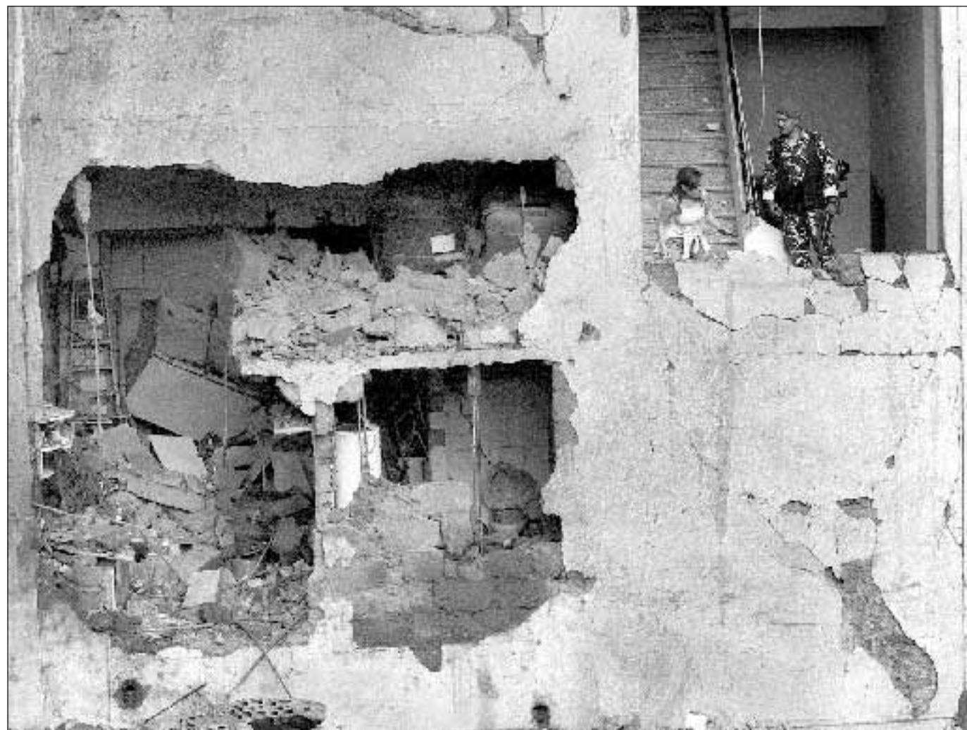
Una palazzina distrutta dall'esplosione di un colpo di mortaio. Foto di Wael Hamzeh/Ansa-Epa
